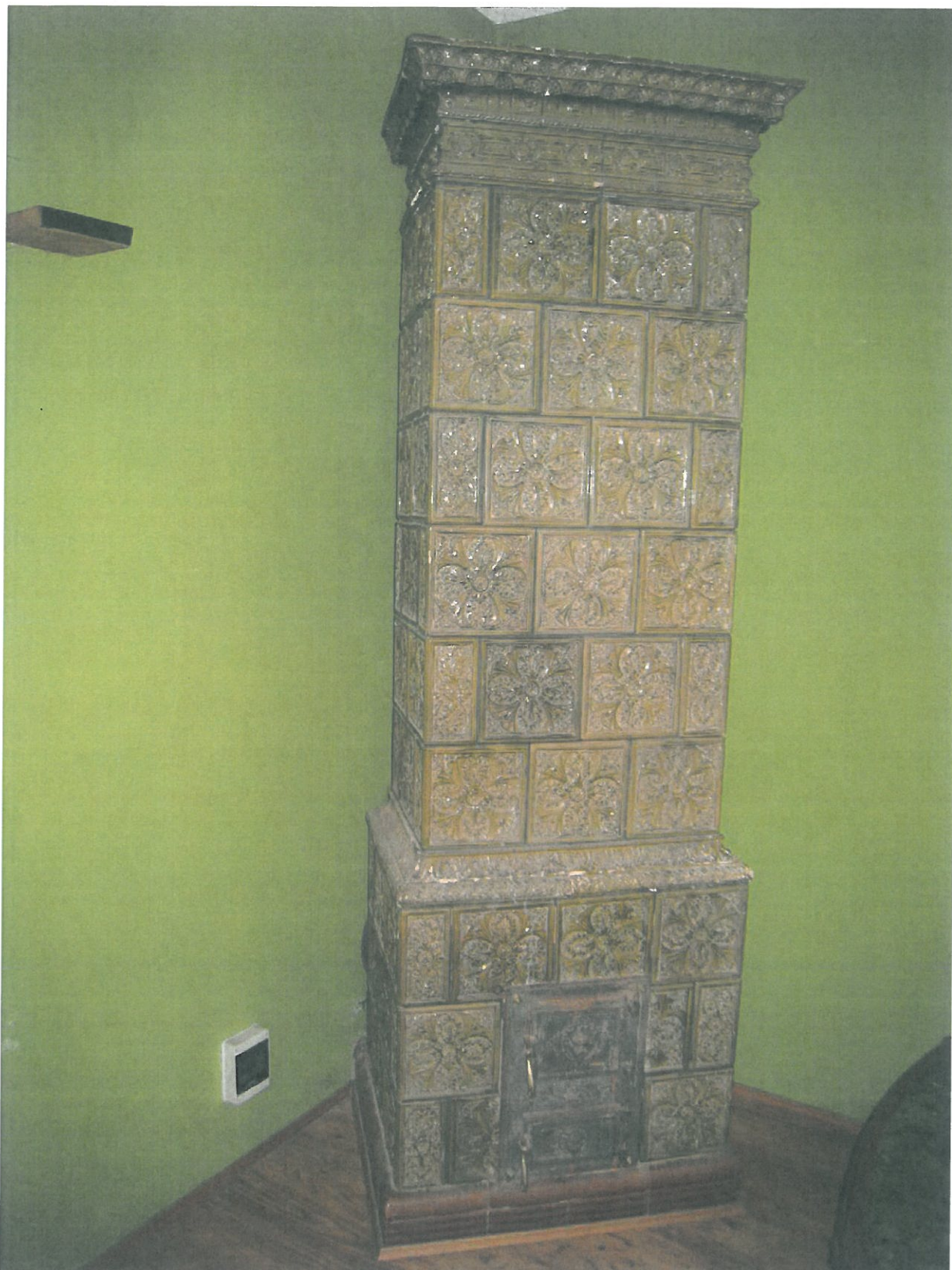
Fot. nr 21 – Kossakówka – Plac Kossaka 4, Kraków. Zdjęcie pieca nr 1, eklektycznego z firmy J. Niedźwieckiego wykonane przez dr arch. Jacka Chrzęszczewskiego w 2009 r. Widoczne różne odcienie szkliva w kolorze oliwkowym oraz nieoryginalna baza pochodząca z pieca modernistycznego w kolorze ciemnoróżowym, identycznym jak piec nr 2. Na dolnym profilu fryzu widoczne uszkodzenia (por. fot. nr 18).
