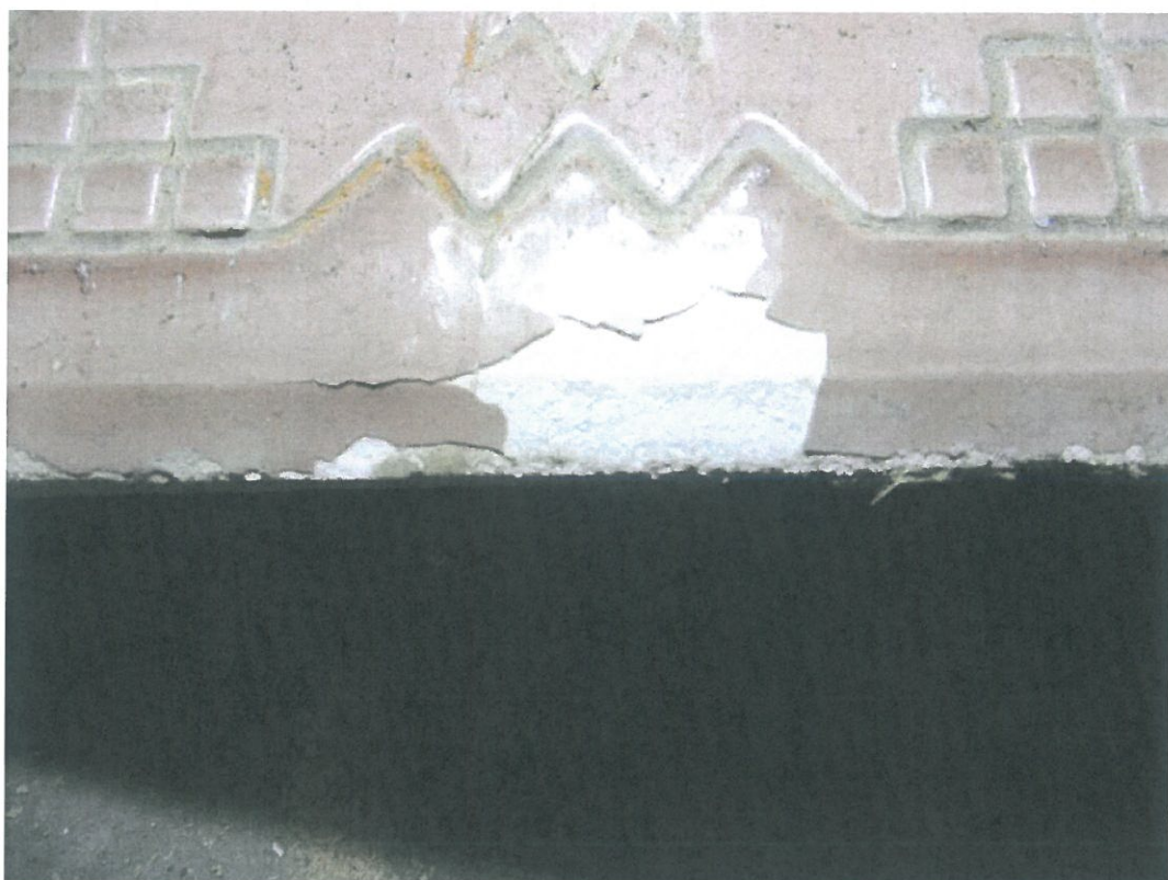
Fot. nr 30, 31 – Kossakówka – Plac Kossaka 4, Kraków. Kafle pieca nr 2 z odpadającym szkliwem w wyniku przemrożenia. Strzałkami oznaczone kafle o innym wzorze zastosowane w niewidocznych częściach pieca od strony ściany (por. fot. nr 32). Na dolnym zdjęciu widoczny proces odpadania szkliwa w wyniku spudrowania angoby na skutek przemrożenia kafli. fot. Andrzej Karbowski – marzec 2021 r.
