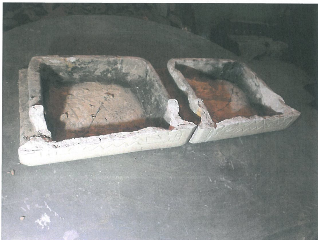
Fot. nr 56, 57 – Kossakówka – Plac Kossaka 4, Kraków. Pęknięty na trzy części kafeł narożnikowy pieca nr 3. Na dolnym zdjęciu dwa podobne kafle w trakcie klejenia. fot. Andrzej Karbowski – czerwiec, lipiec 2021 r.
