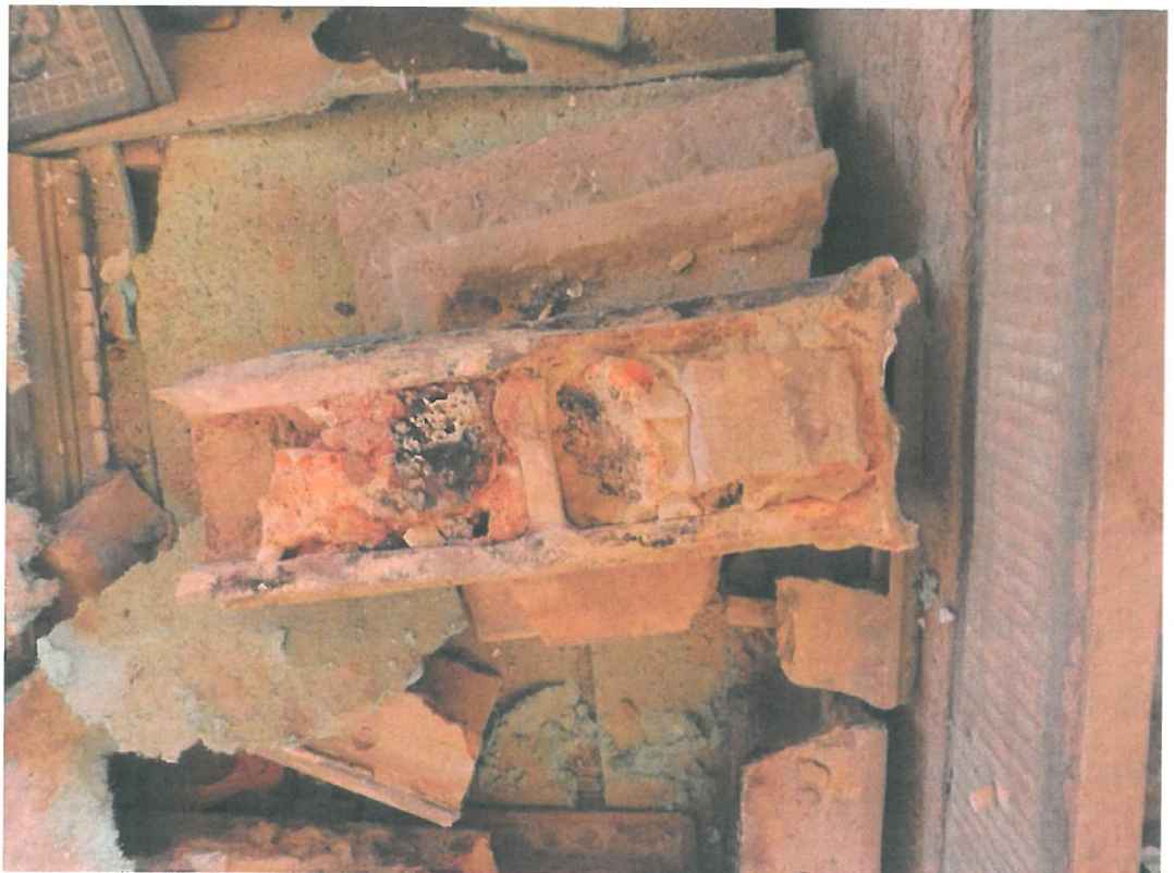
Fot. nr 7, 8 – Kossakówka – Plac Kossaka 4, Kraków. Fragment gzymsu pieca nr 1 z nieusuniętymi wylepkami gliny i fragmentu cegły. fot. Andrzej Karbowski – styczeń 2021 r.
