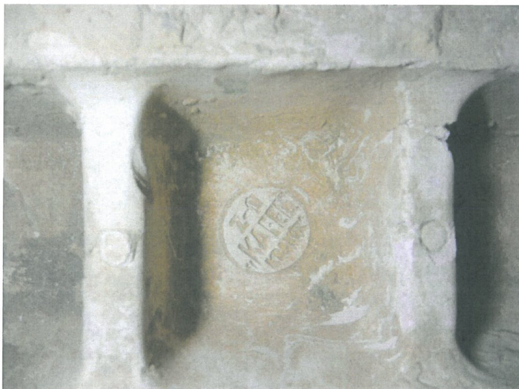
Fot. nr 44, 45 –Kossakówka – Plac Kossaka 4, Kraków. Baza pieca z zielonych kafli ze spółdzielni „KAFEL” przy ul. Balickiej z widoczną na odwrociu sygnaturą. fot. Andrzej Karbowski – marzec 2021 r.
