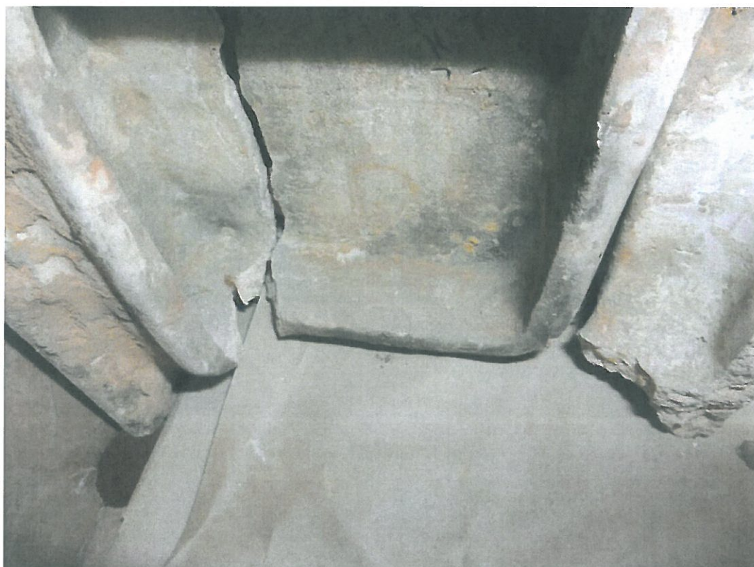
Fot. nr 28, 29 – Kossakówka – Plac Kossaka 4, Kraków. Pęknięty kafel narożnikowy – kolor przełomu wskazuje, że był pęknięty jeszcze w czasie eksploatacji pieca nr 2. Widok od strony lica i odwrocia. fot. Andrzej Karbowski – marzec 2021 r.
