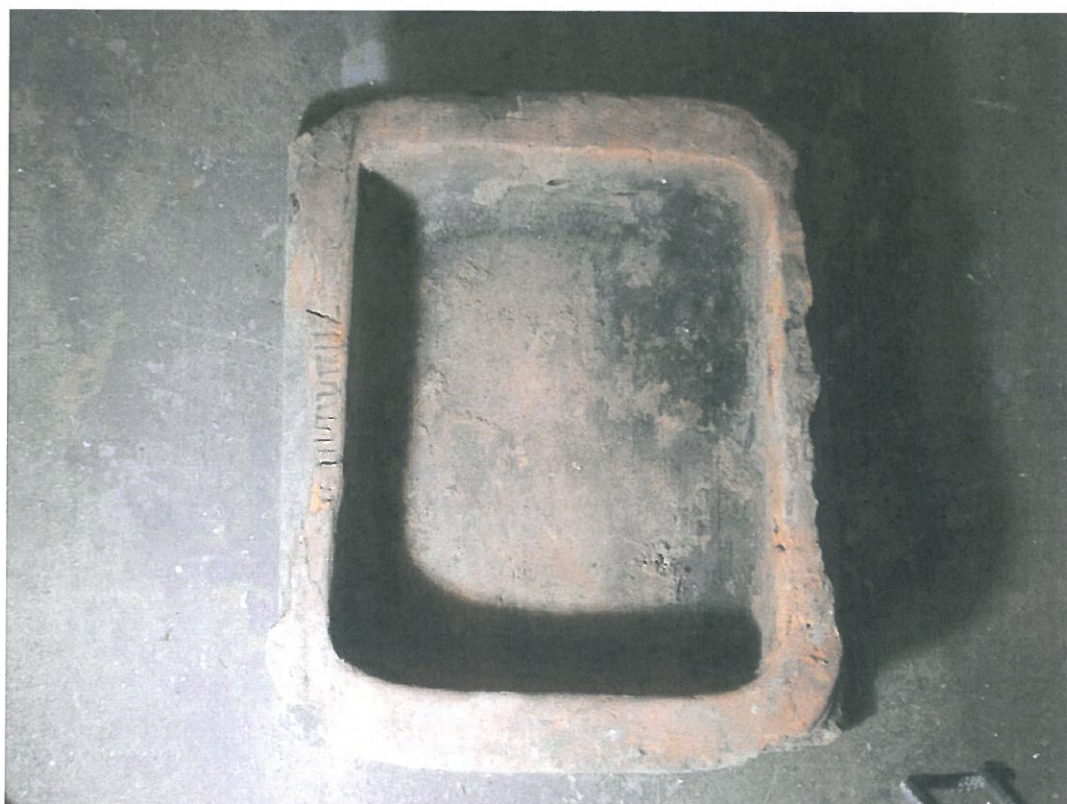
Fot. nr 72, 73 – Kossakówka – Plac Kossaka 4, Kraków. Bardzo zniszczony kafel secesyjny firmy HOROWITZ – sygnatura widoczna na odwrociu na kołnierzu kafla. Druga część sygnatury na przeciwnym kołnierzu nie zachowała się. fot. Andrzej Karbowski – lipiec 2021 r.
