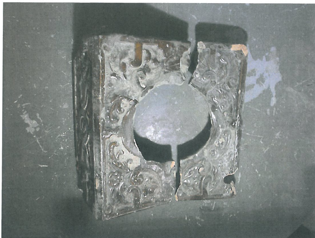
Fot. nr 66, 67 – Kossakówka – Plac Kossaka 4, Kraków. Dwa kafle z ornamentem okuciowym – licowy i narożnikowy. W kafle narożnikowym mocno zniszczonym z otworem wyczystki w prawym dolnym narożniku widoczne wtórne przebicie – prawdopodobnie ślad po kablu ogrzewania elektrycznego. fot. Andrzej Karbowski – lipiec 2021 r.
