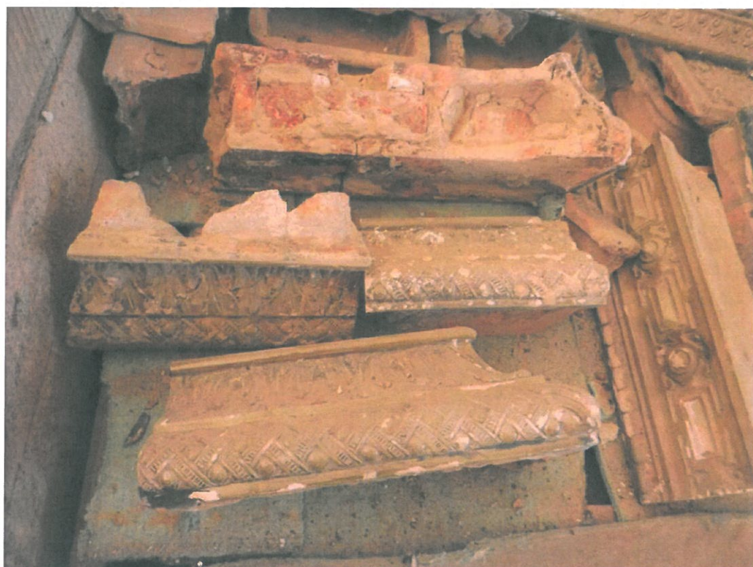
Fot. nr 15, 16 – Kossakówka – Plac Kossaka 4, Kraków. Fragmenty gzymsu środkowego z uszkodzeniami mechanicznymi (obicia, pęknięcia) i chemicznymi – spudrowanie angoby i odpadanie szkliwa będące wynikiem przemrożenia kafli.
