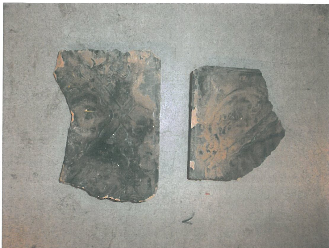
Fot. nr 48, 49 – Kossakówka – Plac Kossaka 4, Kraków. Przemieszczone kafle pieca nr 3, nr 4 i 5 oraz pieca nr 7 w południowo-wschodnim narożniku pomieszczenia nr 2.2 na parterze. Prawie wszystkie kafle narożnikowe miały nieusunięte wylepki z gliny i fragmentów starszych ozdobnych kafli. Na dolnym zdjęciu widoczne dwa takie fragmenty. fot. Andrzej Karbowski – kwiecień, listopad 2021 r.
