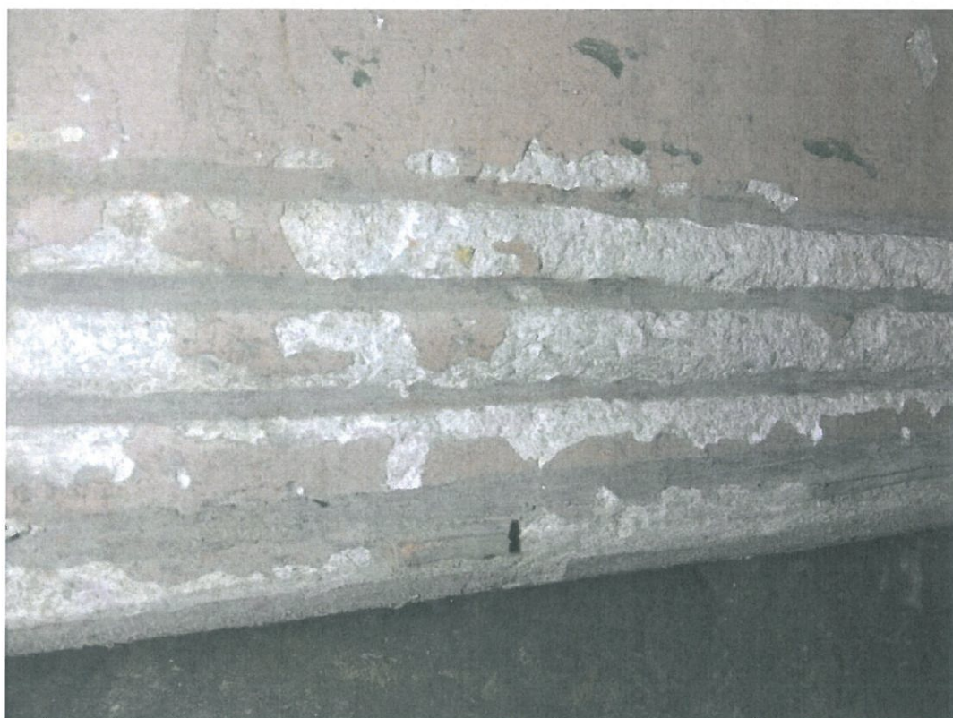
Fot. nr 34, 35 – Kossakówka – Plac Kossaka 4, Kraków. Zniszczone elementy bazy prawdopodobnie pieca nr 2 – całkowicie zniszczony element na skutek spudrowania grubej warstwy angoby – uszkodzenie chemiczne, które mogło nastąpić na skutek częstej zmiany wilgotności podłoża pieca np. w niepodpiwniczonej części willi. Na dolnym zdjęciu liczne obicia na profilach dolnej części bazy – zniszczenia mechaniczne często występujące na elementach bazy poniżej drzwiczek paleniska. fot. Andrzej Karbowski – marzec 2021 r.
