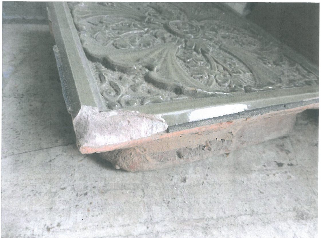
Fot. nr 9, 10 – Kossakówka – Plac Kossaka 4, Kraków. Pęknięty kafel narożnikowy wzmocniony drutem przed poprzednią przebudową. Na dolnym zdjęciu widoczne niedawne uszkodzenie (obicie) narożnika oraz fragment niedolanego szkliwa na fazie kafla. Widoczne również relikty ostatniego fugowania.
