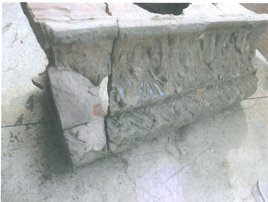
Fot. nr 24, 25 – Kossakówka – Plac Kossaka 4, Kraków. Fragmenty gzymsu środkowego z bardzo zniszczonym, niewielkim elementem środkowej części frontu – dolne zdjęcie – spudrowana warstwa angoby straciła całkowicie kształt reliefu. fot. Andrzej Karbowski – marzec 2021 r.
