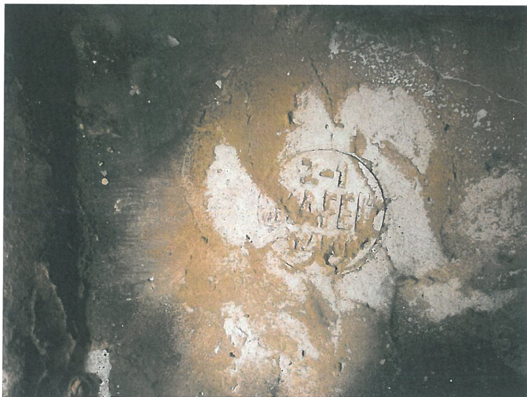
Fot. nr 58, 59 – Kossakówka – Plac Kossaka 4, Kraków. Mocno obity kafel pieca nr 4 lub 5 ukazujący budowę kafla z białej mieszanki gliny. Widoczna na dolnym zdjęciu sygnatura spółdzielni „KAFEL” odcisnięta jest na odwrociu z białej gliny.
