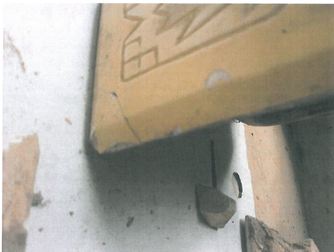
Fot. nr 54, 55 – Kossakówka - Plac Kossaka 4, Kraków. Doklejony w pierwotnym miejscu ubity w czasie składowania narożnik kafla pieca nr 3. Widoczne również drobne obicia i przetarcia szkliva. fot. Andrzej Karbowski – czerwiec 2021 r.
