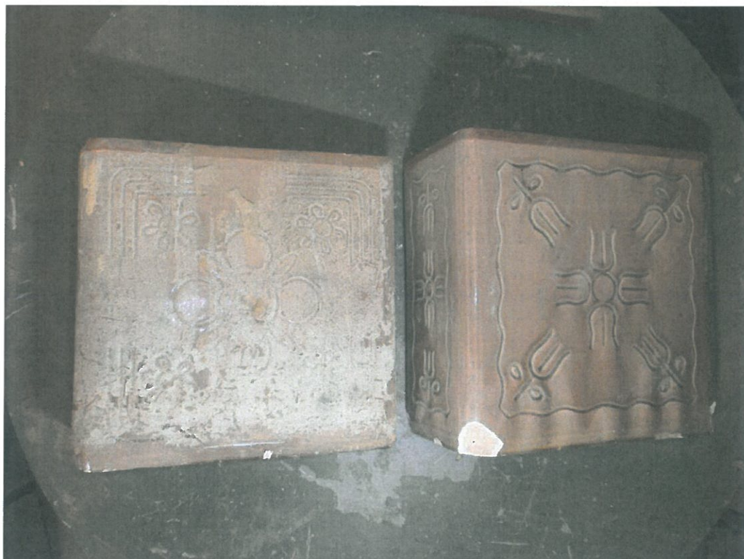
Fot. nr 62, 63 – Kossakówka – Plac Kossaka 4, Kraków. Dwa typowe kafle pieca nr 6. Widoczne różne odcienie ciemnoróżowego szkliwa i kierunek spływu szkliwa w czasie wypalania. Na dolnym zdjęciu dwa kafle narożnikowe – po lewej stronie kafel o innym wzorze z tylnej niewidocznej części pieca nr 6. fot. Andrzej Karbowski – czerwiec 2021 r.
