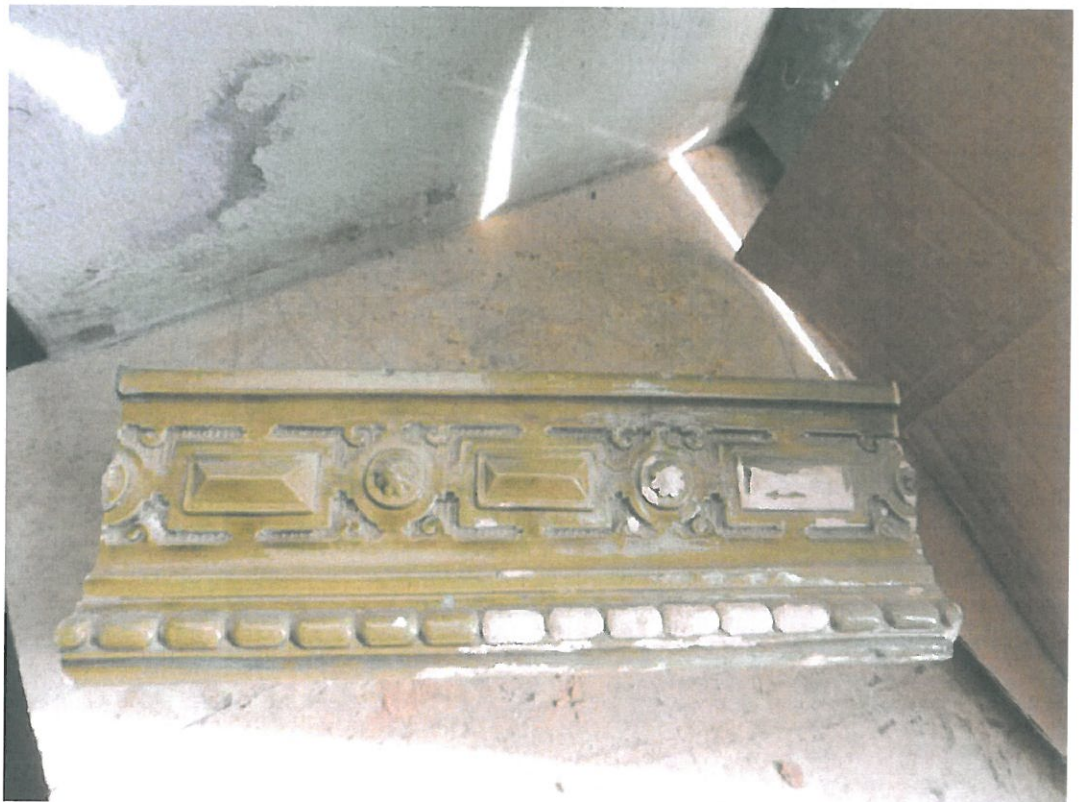
Fot. nr 17, 18 – Kossakówka – Plac Kossaka 4, Kraków. Świeże obicia narożników kafli i odpryski szkliwa – uszkodzenia chemiczne na fryzie gzymsu wieńczącego powstałe jeszcze przed rozbiórką pieca (por. fot. nr 21).
