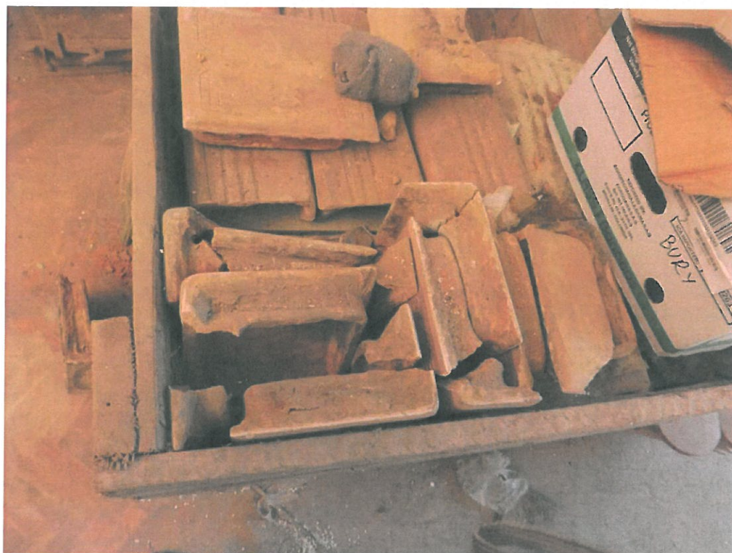
Fot. nr 26, 27 – Kossakówka – Plac Kossaka 4, Kraków. Kafel licowy pieca nr 2 z wytwórni „KAFEL” zakład nr 1 przy ul. Balickiej. Na dolnym zdjęciu wiele popękanych kafli narożnikowych. fot. Andrzej Karbowski – marzec 2021 r.
