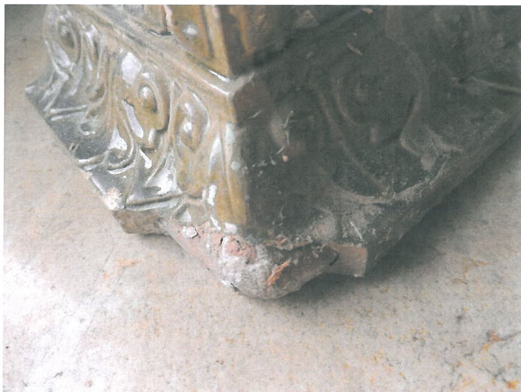
Fot. nr 11, 12 – Kossakówka – Plac Kossaka 4, Kraków. Fragment narożnika gzymsu wieńczącego pieca nr 1 z uszkodzonym profilem górnym. Na dolnym zdjęciu zbliżenie tego uszkodzenia. fot. Andrzej Karbowski – styczeń 2021 r.
